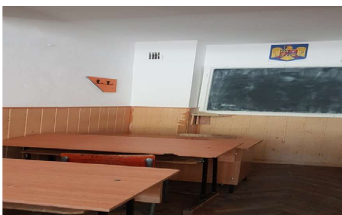
Figura 3 – Finisaje interioare – pereți și pardoseală
