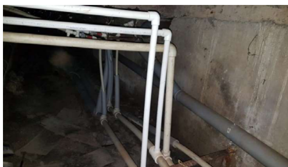
Figura 9 - Conducte PPR
